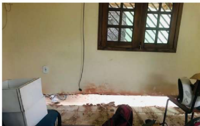
Devido aos problemas com infiltração advinda do solo, foi necessária realizar recortes na parte inferior das paredes para refazer essa parte estrutural, que não estavam previstos no projeto original.
